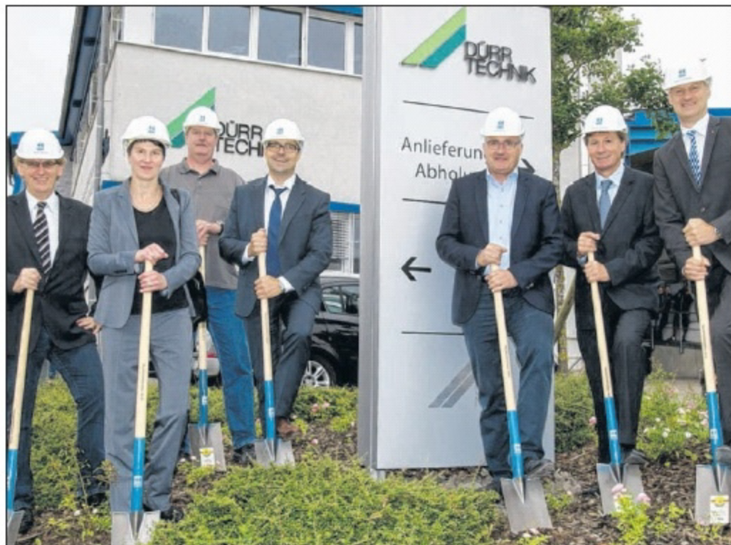
Gemeinsamer erster Spatenstich für den vier Millionen Euro teuren Erweiterungsbau von Dürr Technik in Bietigheim-Bissingen (von links): Wulf Werner, Gaby Freund-Fahrmer, Andreas Leicht, Andreas Ripsam, Horst Köhler, Roland Wägerle und Martin Dürrstein.
