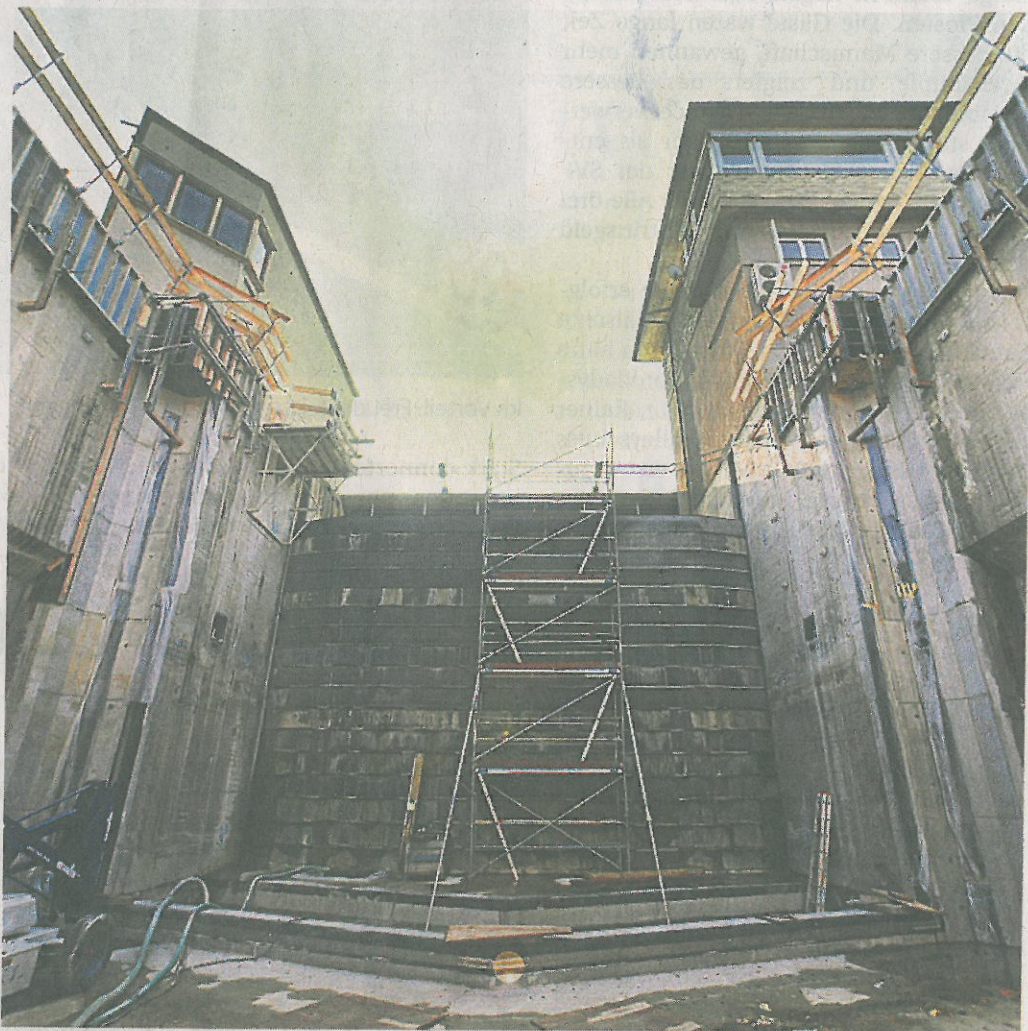
Mit einem Notverschluss ist die untere Ausfahrt der Schleusenkammer versehen. Die Arbeiten in der Kammer werden unterhalb des Wasserspiegels gemacht.
