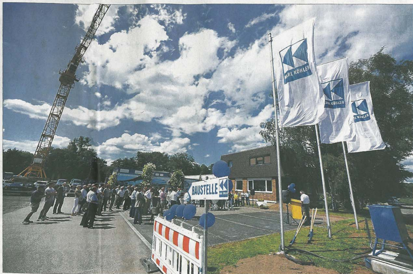
Spatenstich für den Neubau: Die Karl Köhler GmbH baut ein neues Büro- und Sozialgebäude am Firmensitz in Besigheim.
