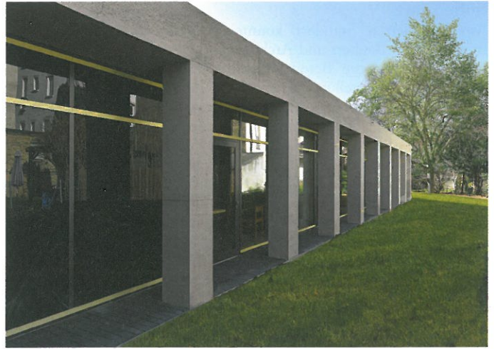
Der Flachdachbau neben dem Oval erscheint dagegen in Sichtbetonqualität. Fotos: Mühleisen+Partner Planungsgesellschaft/Kurt Entenmann
