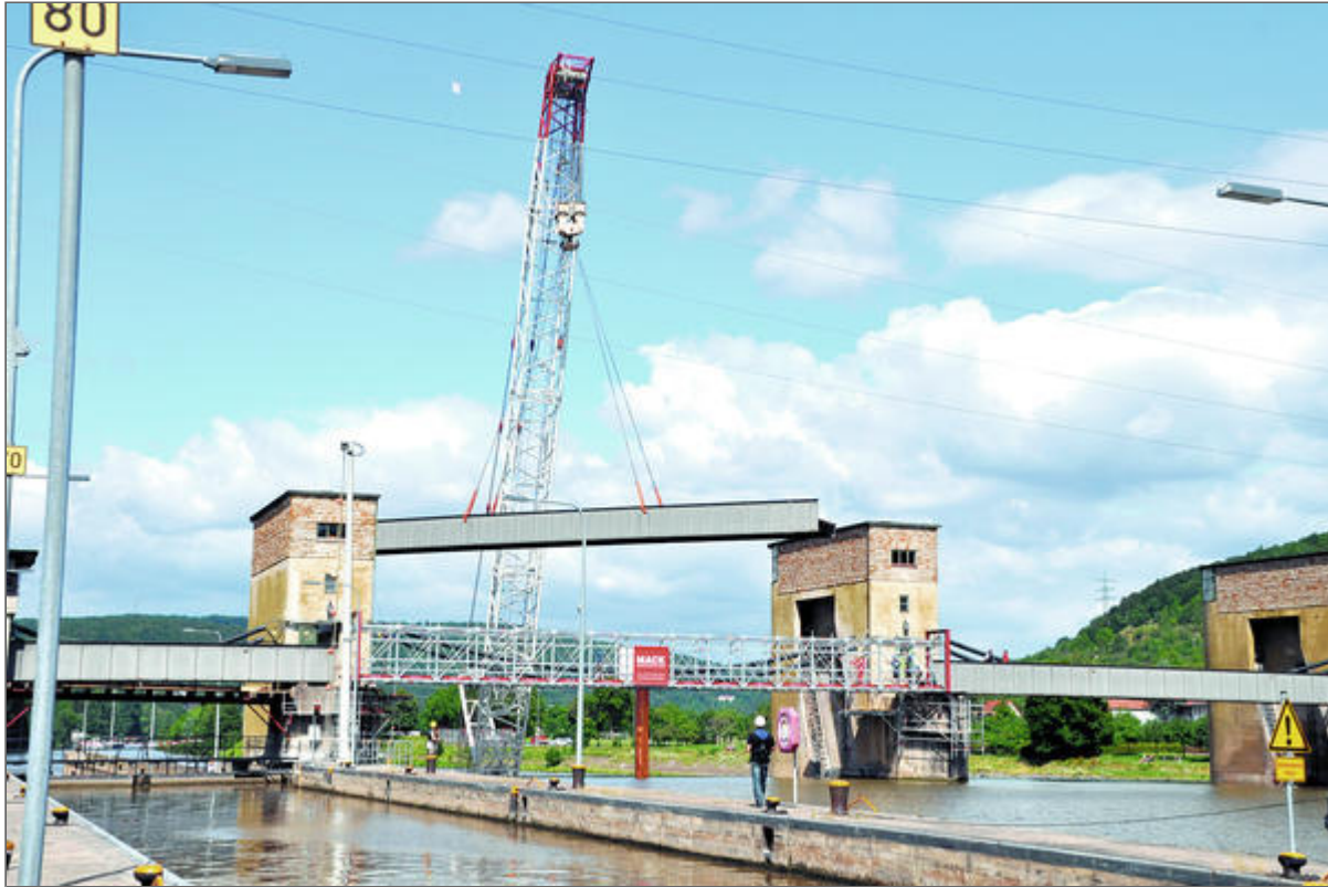
Am Haken: Das erste von fünf Stegteilen wird aus seiner Verankerung herausgehoben. Foto: Stephanie Kern
