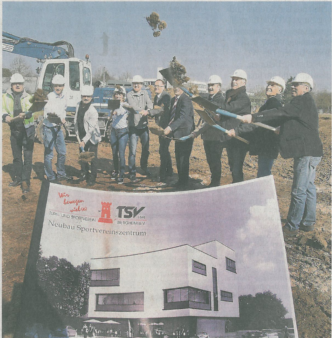
Alle Mann ran: Spatenstich im Ellental. In 13 Monaten soll der Neubau stehen.
