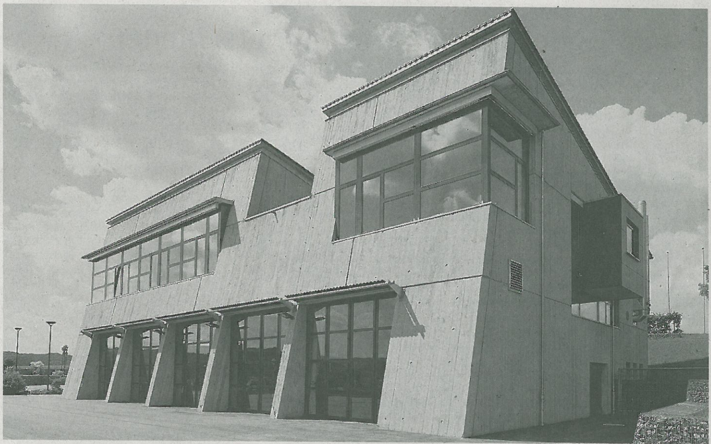
Die gewünschte Solidität und robuste Oberfläche des neuen Feuerwehrhauses wurden mit Liapor-Leichtbeton in Sichtbetonoptik umgesetzt.
