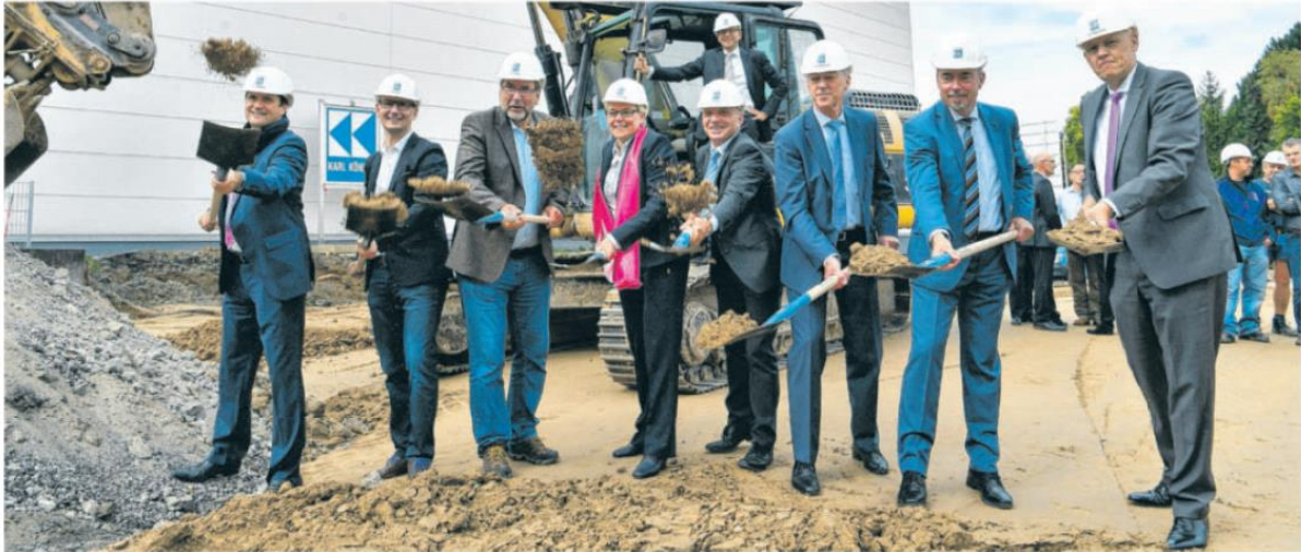
Spatenstich bei Teamtechnik in Freiberg mit Geschäftsführer Stefan Roßkopf (Im Bagger) und (von links): Bürgermeister Dirk Schalble, Mathias Orth, Architekturbüro KMB, Günter Teske, Bauunternehmung Karl Köhler, Katja Scheibling und Klaus Feiss, Teamtechnik, Klaus Burghardt, Sparkasse Pforzheim-Calw, Michael Müller, Bautech, sowie Holger Plaßmann, Deutsche Anlagen-Leasing. Foto: Martin Kalb
