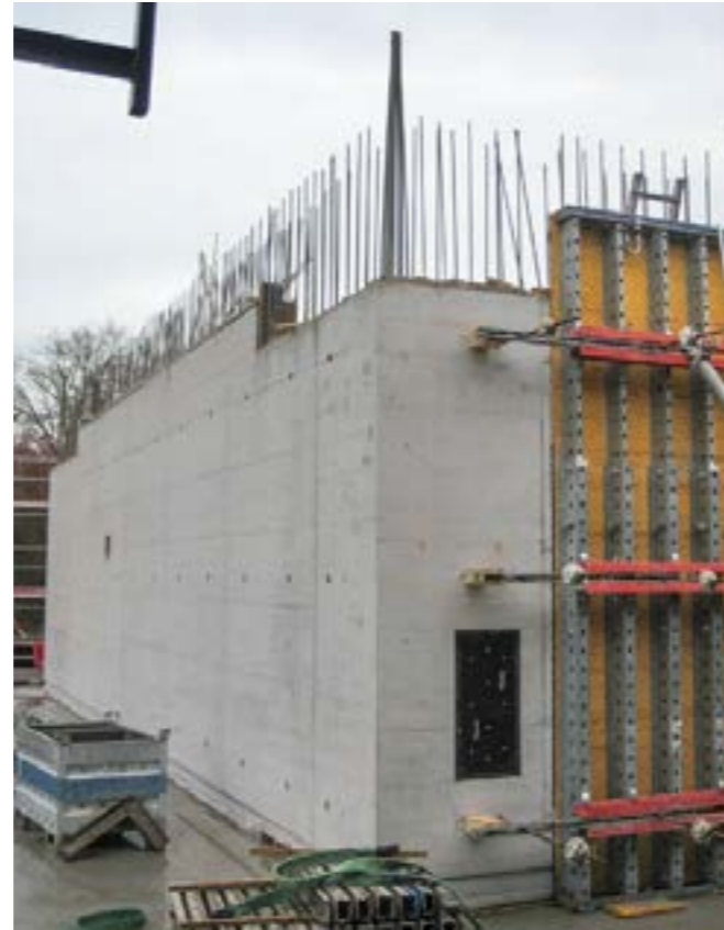
Treppenbaus ausgeschalt, Fläche wurde später gespitzt
