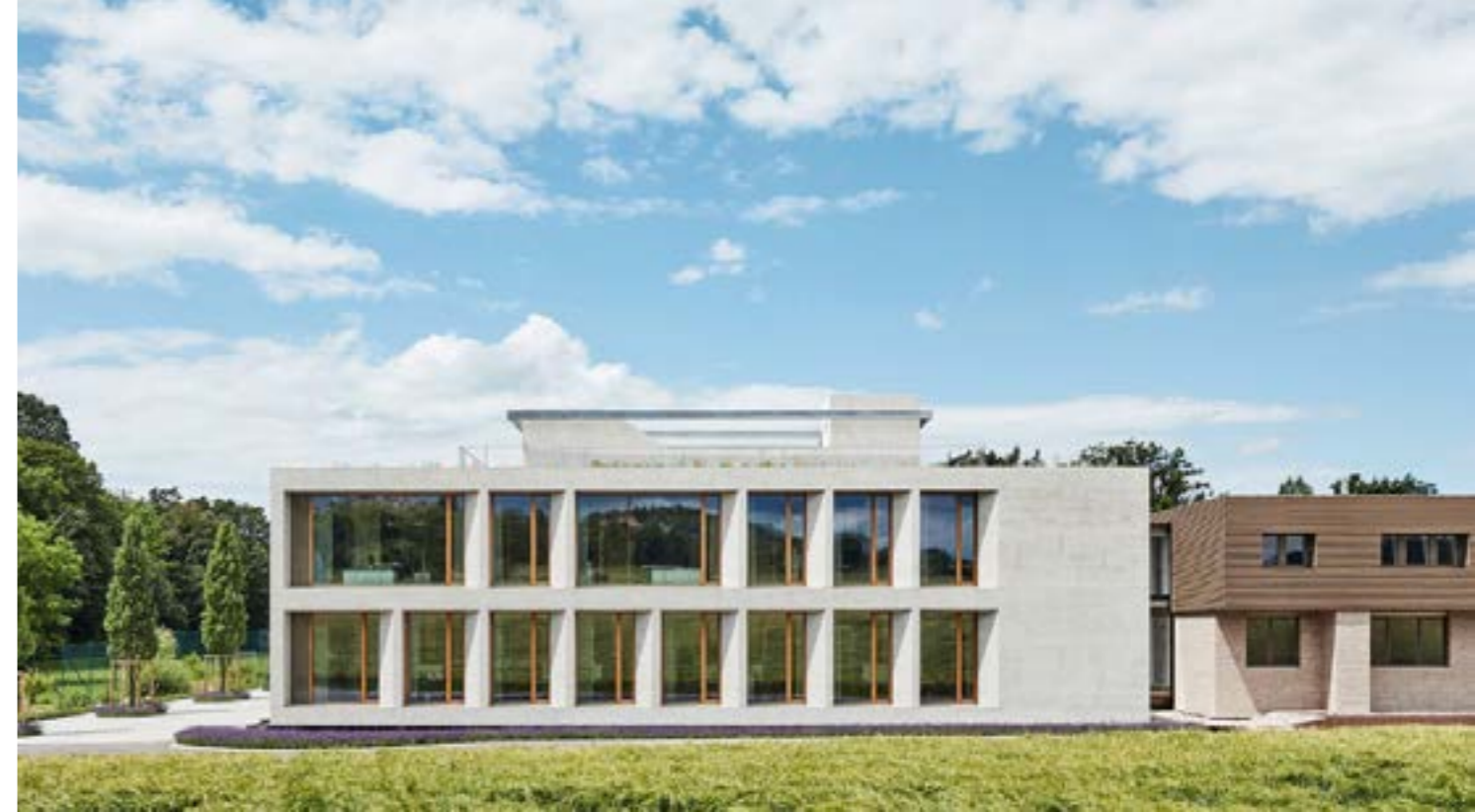
Neubau und Altbau der Karl Köbler GmbH
