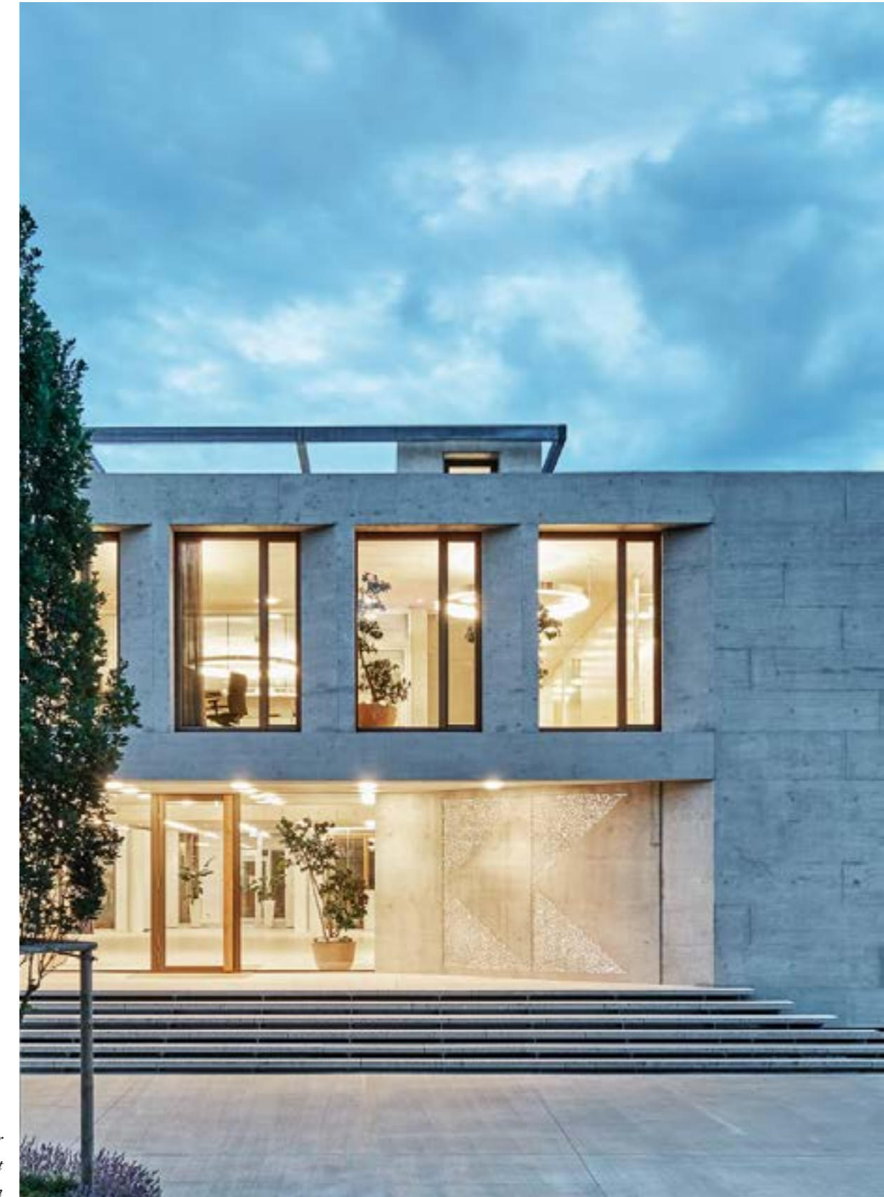
Fertiger Eingangsbereich mit transluzentem Beton
