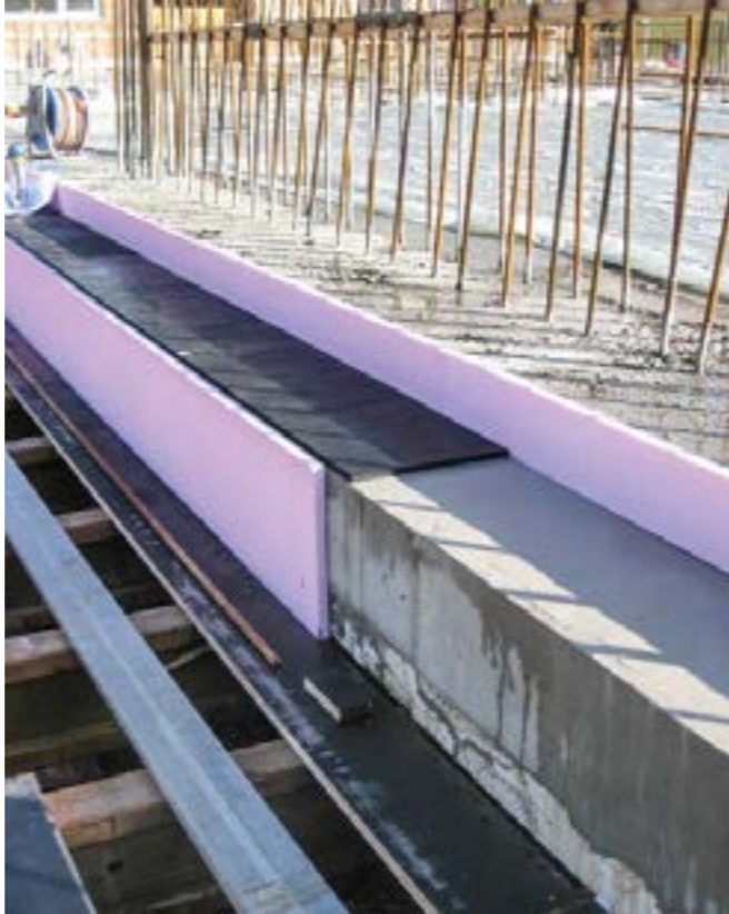
Lager der Fassade auf Konsole
