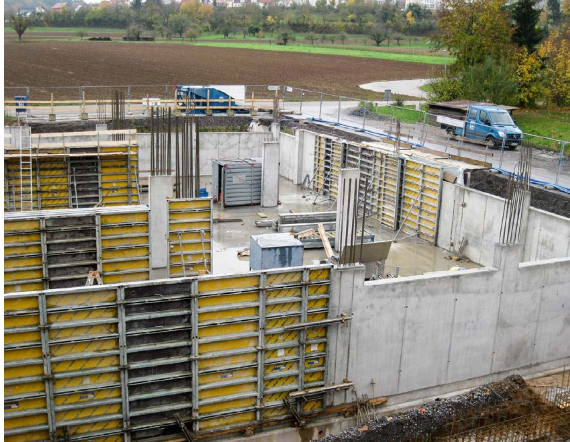
Tiefgarage mit konventioneller Stahlrahmenschalung geschalt
