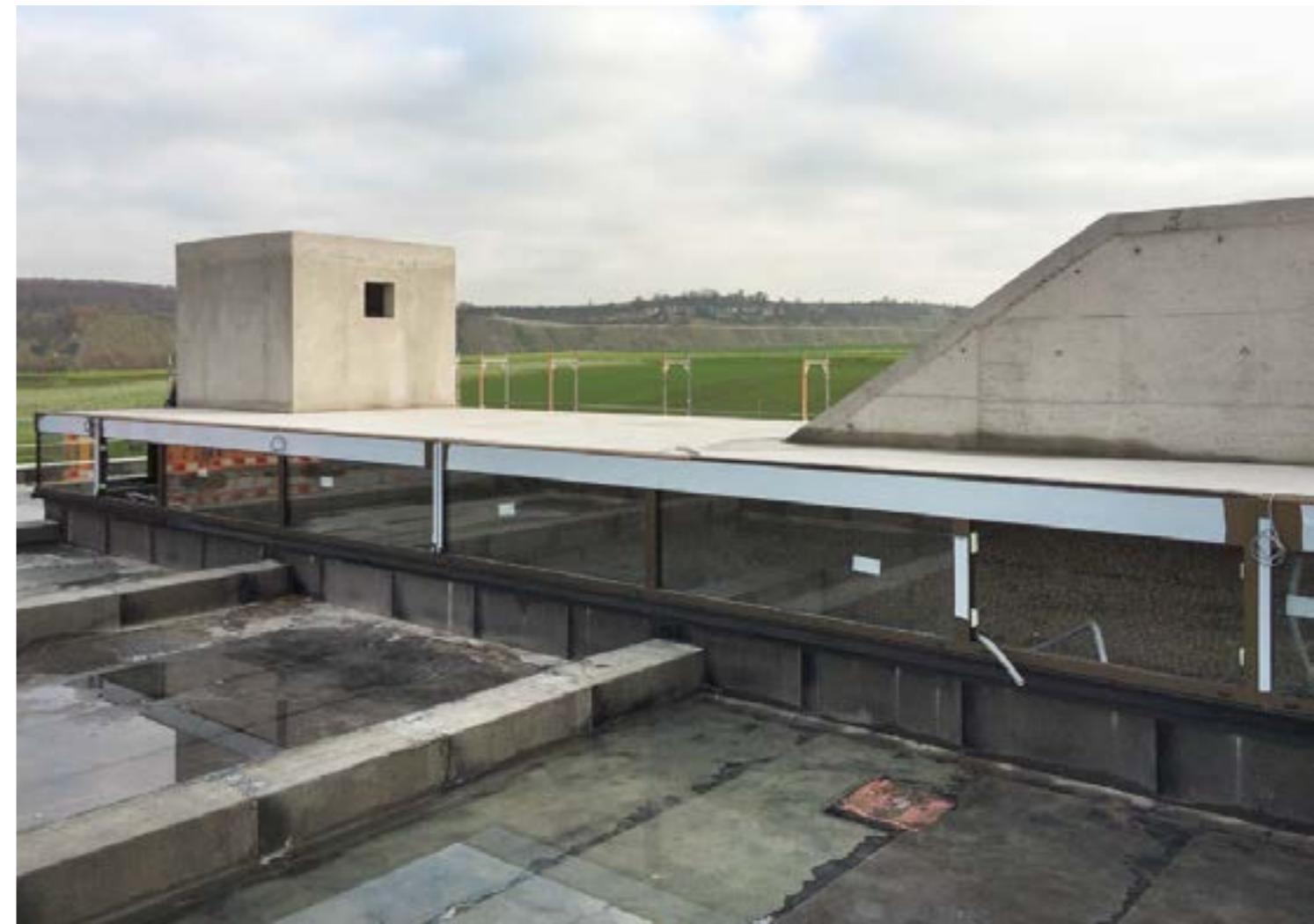
Dachaufbauten im Rohbau mit Oberlichtern
