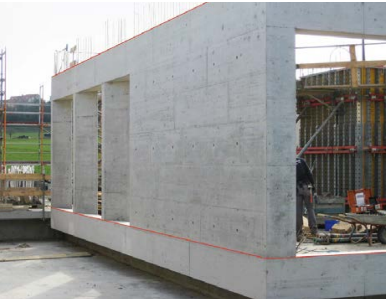
Horizontale Betonierabschnitte (rot dargestellt)
