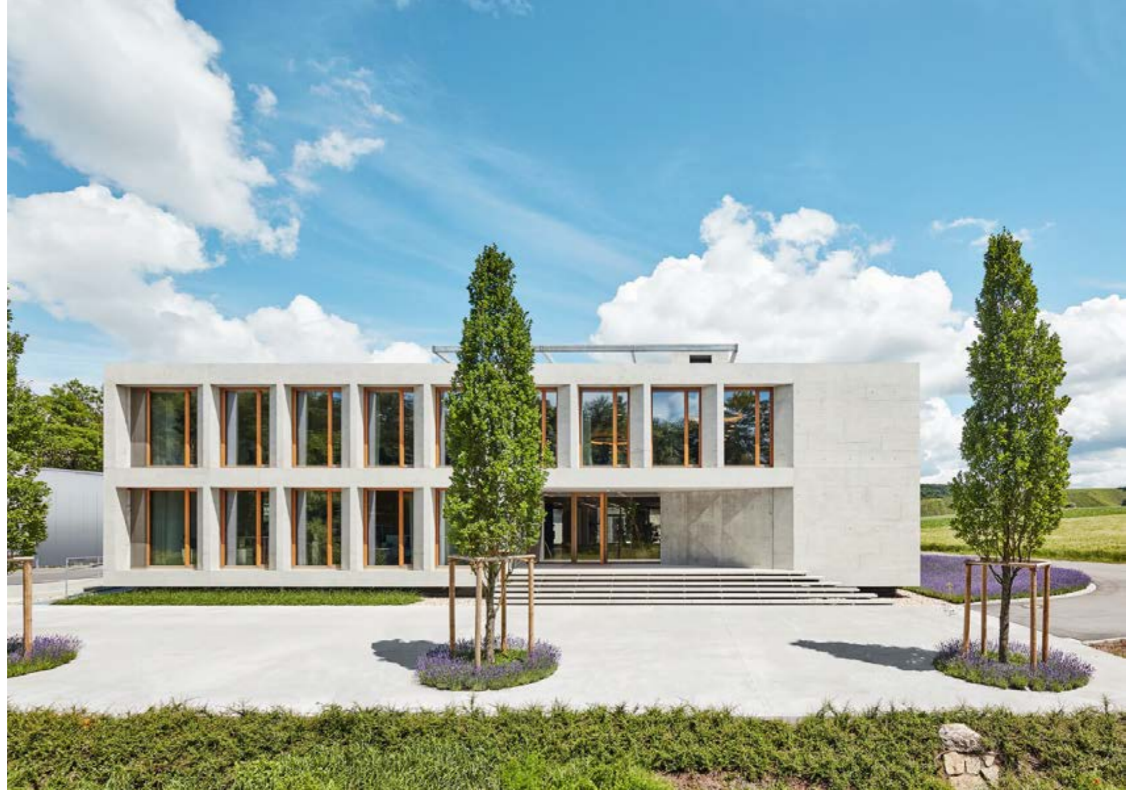
Eingangssituation des Neubaus an der Jabnstraße
