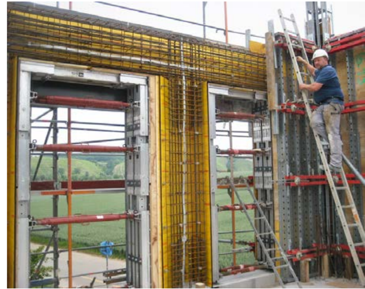
Ansicht von innen, spindelbare Gesperre in den Öffnungen
