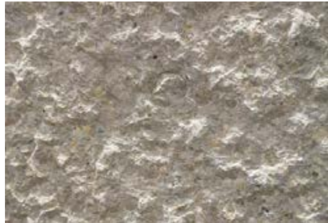
Verschlossener Konus in gespitzter Oberfläche
