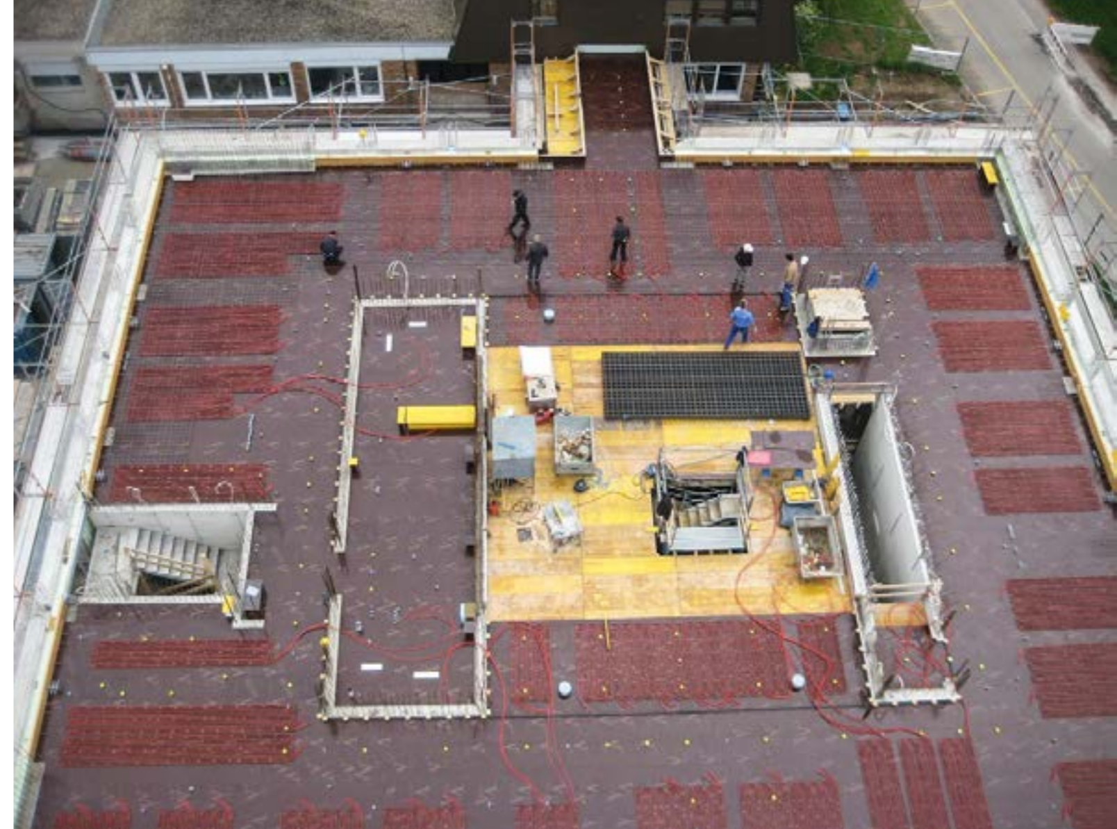
Schalung Decke über EG mit eingelegten Schleifen zur Betonkernaktivierung
