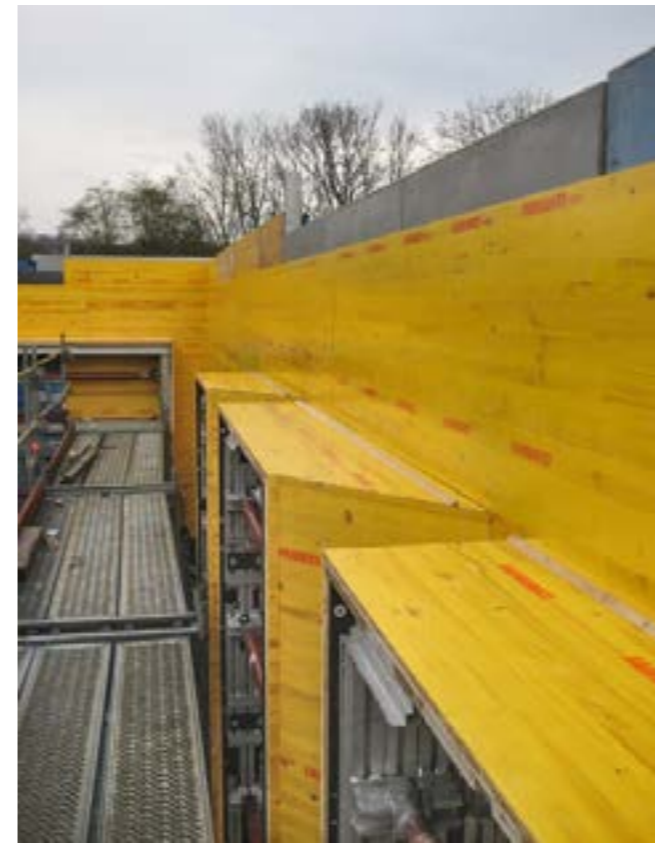
Fertig geschalte Sichtflächen
