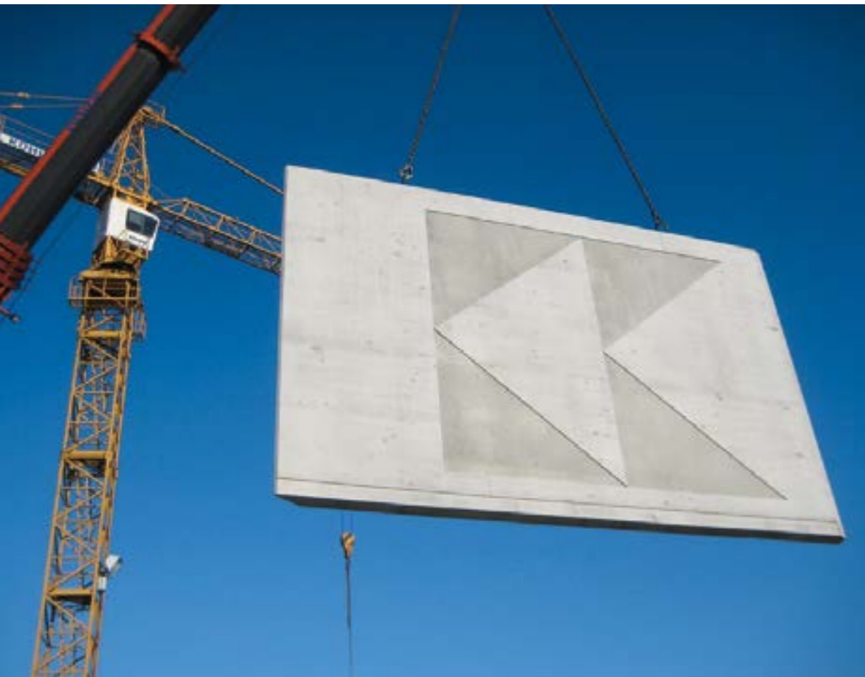
Versetzen der Wandscheibe in transluzentem Beton
