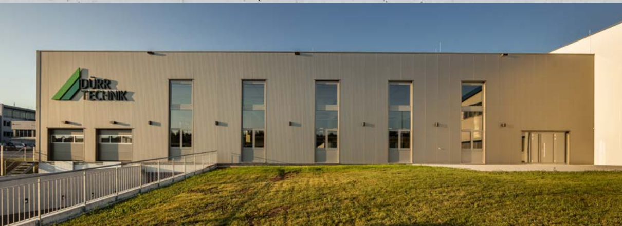
Produktions- und Lagerhalle, Bietigheim-Bissingen
