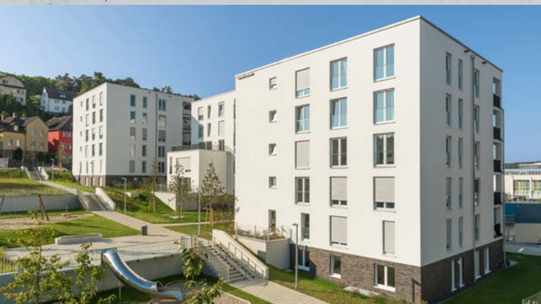
3 Mehrfamilienhäuser, Stuttgart (39 Wohneinheiten)
