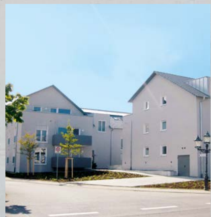
2 Mehrfamilienhäuser, Langensteinbach (21 Wohneinheiten) Ausführung in ARGE
