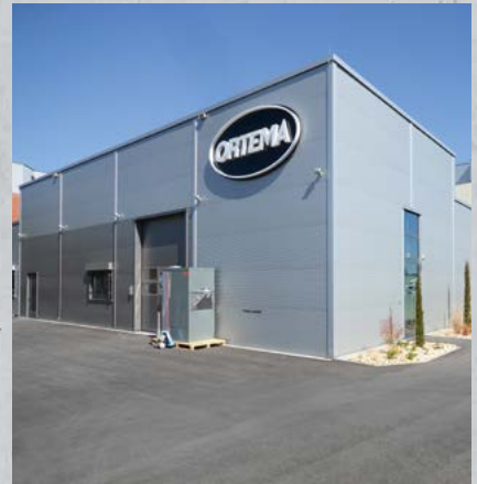
Anbau Büro- und Lagergebäude, Markgröningen
