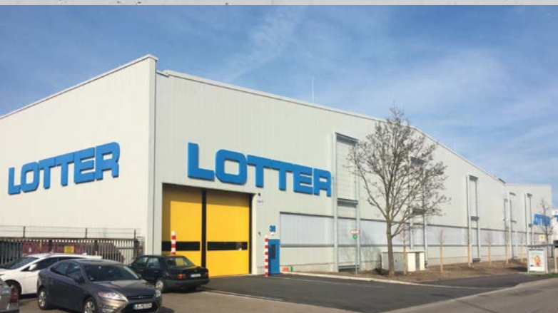
Logistikhalle, Ludwigsburg Ausführung in ARGE
