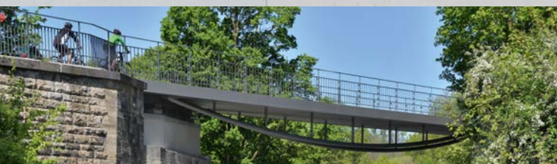
Geh- und Radwegbrücke, Marbach
