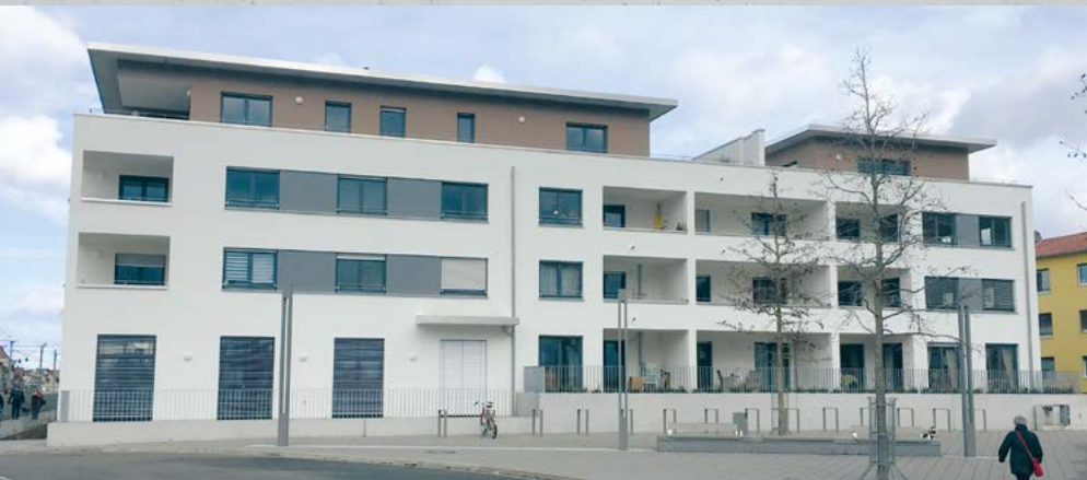
7 Mehrfamilienhäuser, Schriesheim (55 Wohneinheiten) Ausführung in ARGE
