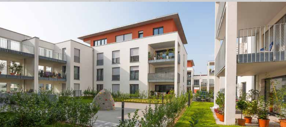
7 Mehrfamilienhäuser, Schriesheim, (45 Wohneinheiten)
