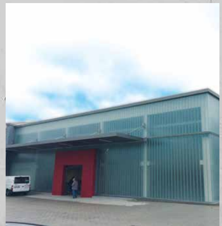
Produktions- und Lagerhalle, Maulbronn
