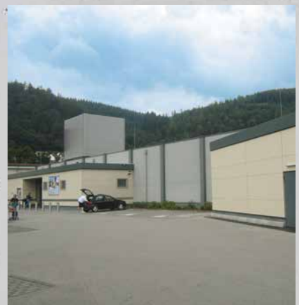
Um- und Anbau SB-Markt, Eberbach
