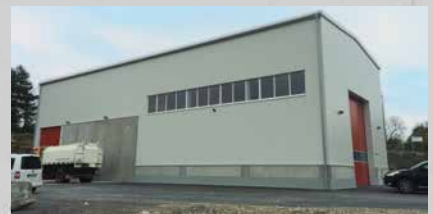
Werkstatthalle, Sindelfingen- Darmsheim
