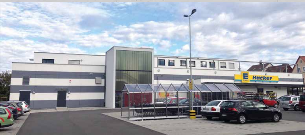
Wohn- und Geschäftsgebäude, Weil im Schönbuch
