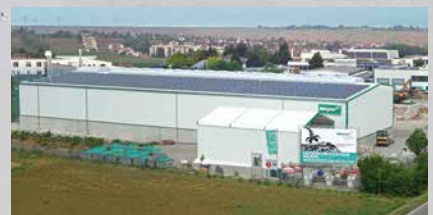
Entsorgungszentrum Neckar, Kirchheim
