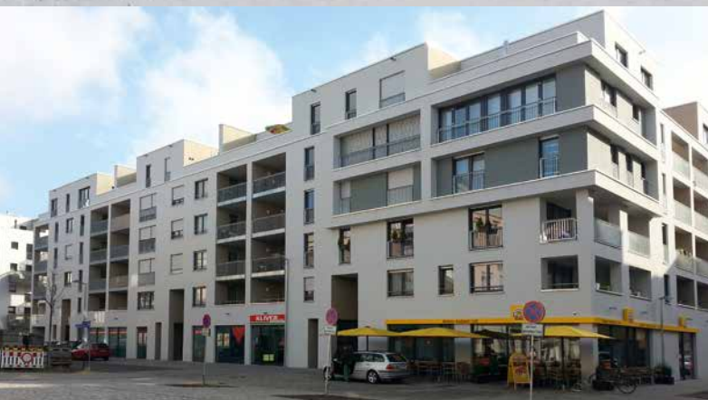
Mehrfamilienhaus, Karlsruhe (42 Wohneinheiten) Ausführung in ARGE
