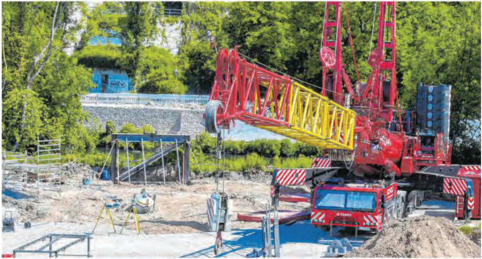
Ein Blick auf die große Baustelle in der Enzaue von Besigheim. Der Kran, mit dem ab Montag die Brückenteile an ihren Platz gehievt werden, wird montiert. Foto: Martin Kalb
