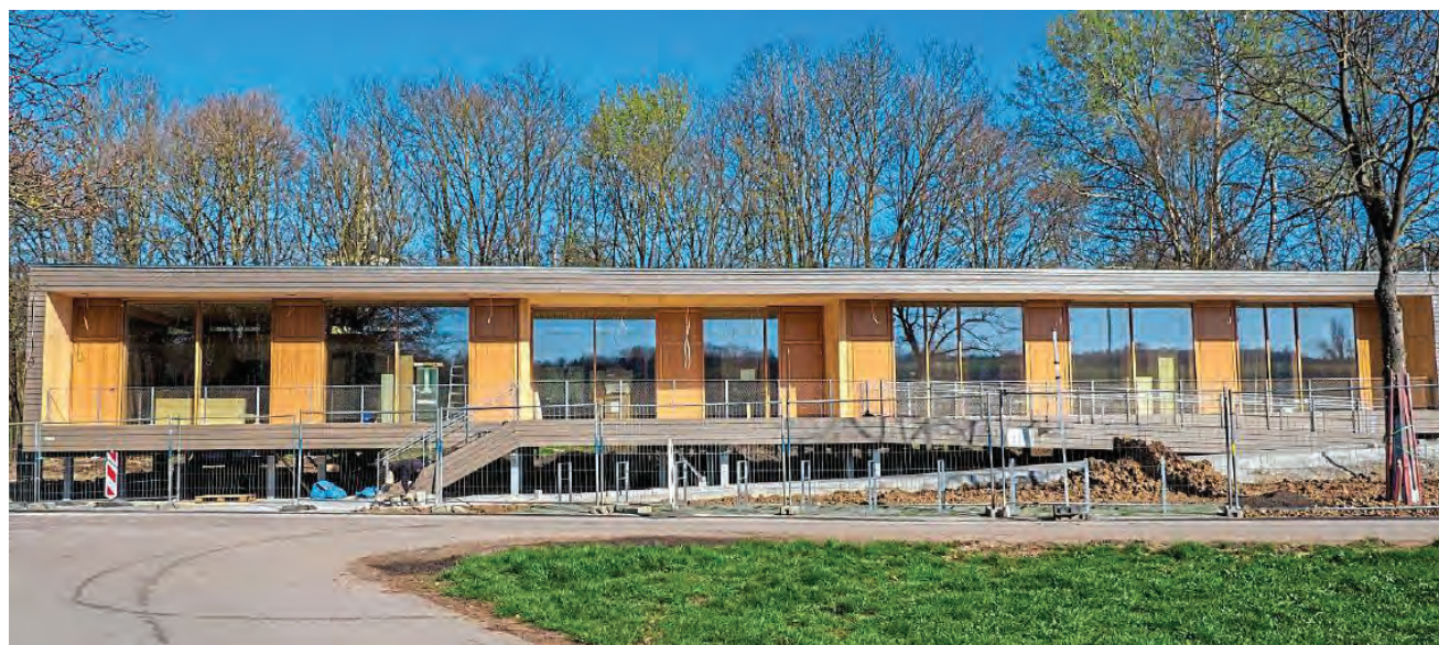
Architektonisches Highlight im Murrtal: das neue Murrer Jugendhaus. Durch die großen Fenster dringt viel Tageslicht in das Gebäude aus Holz. Die Rampe ermöglicht außerdem einen barrierefreien Zugang.
