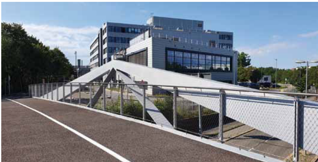
Sprengwerkträgerstruktur als Orteinfahrt nach Sindelfingen © sbp/Stefan Dziewas
