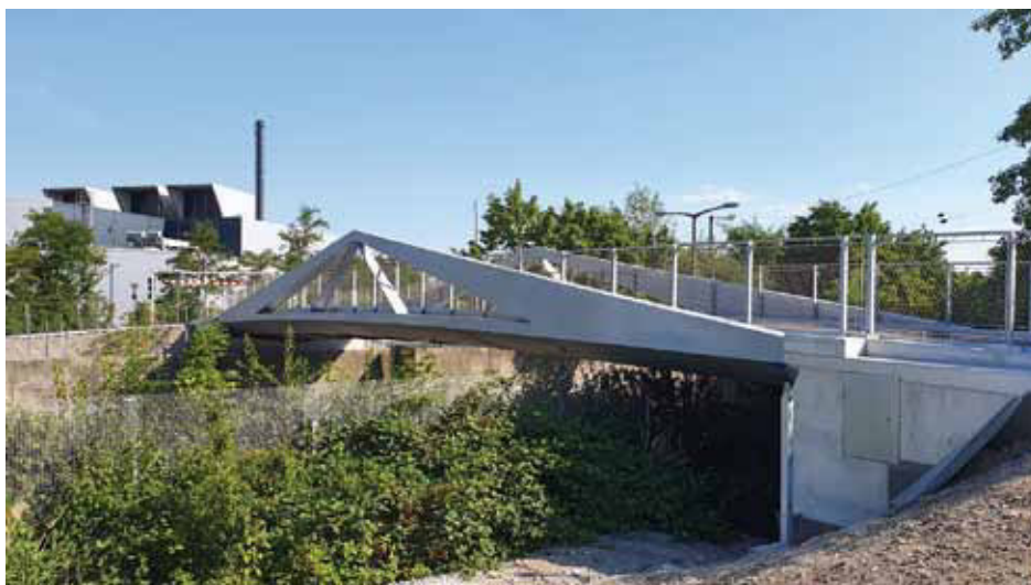
Gelenkige Auflagerung auf zwei Widerlagern © sbp/Stefan Dziewas
