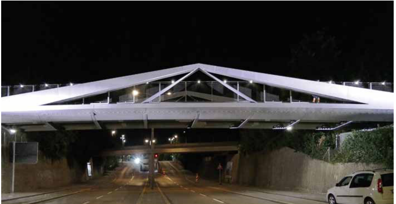
Zeichenhafte Brückenkonstruktion am Ortseingang © sbp/Stefan Dziewas
