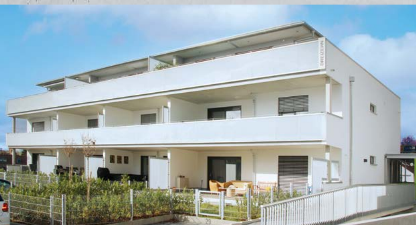
Mehrfamilienhaus (11 Wohneinheiten), Schwieberdingen
