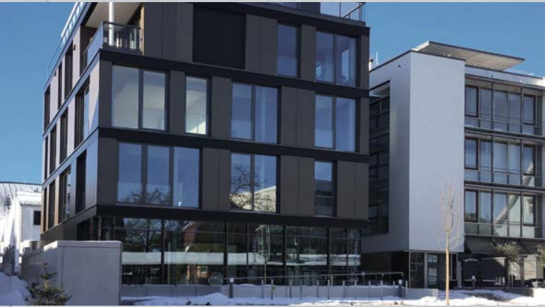
Wohn- und Geschäftshaus, Stuttgart
