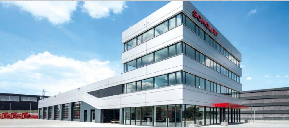
Verwaltungsgebäude mit Lager- und War- tungshallen, Leonberg
