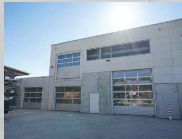
Erweiterung Werkstatthalle, Heilbronn
