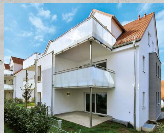
Mehrfamilienhaus (12 Wohneinheiten), Tamm
