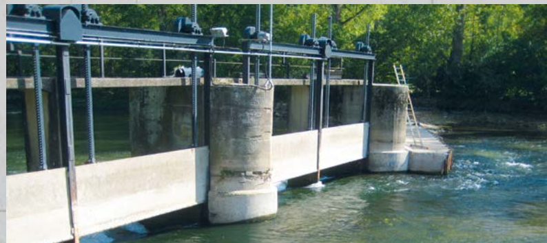
Sanierung Wasserkraftwerk, Bietigheim-Bissingen.
