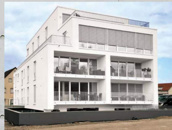
Mehrfamilienhaus, Markgröningen (6 Wohneinheiten)
