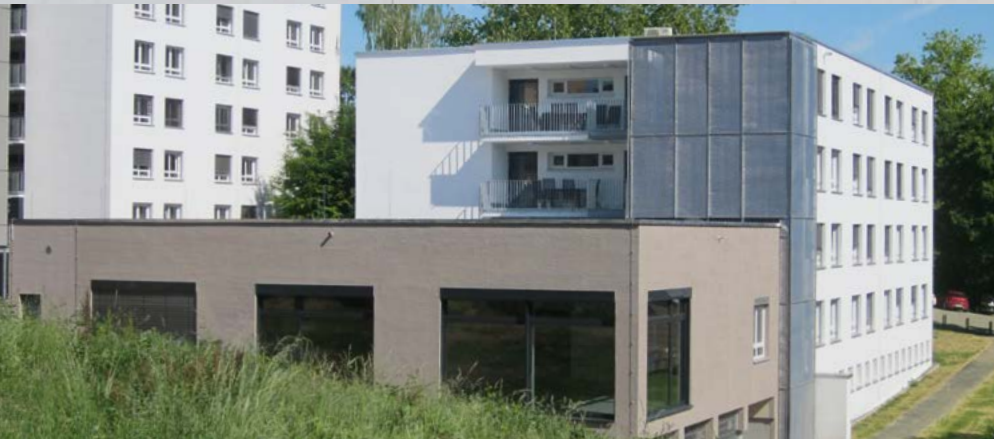
Umbau und Anbau Wohnheim Klinik, Heilbronn
