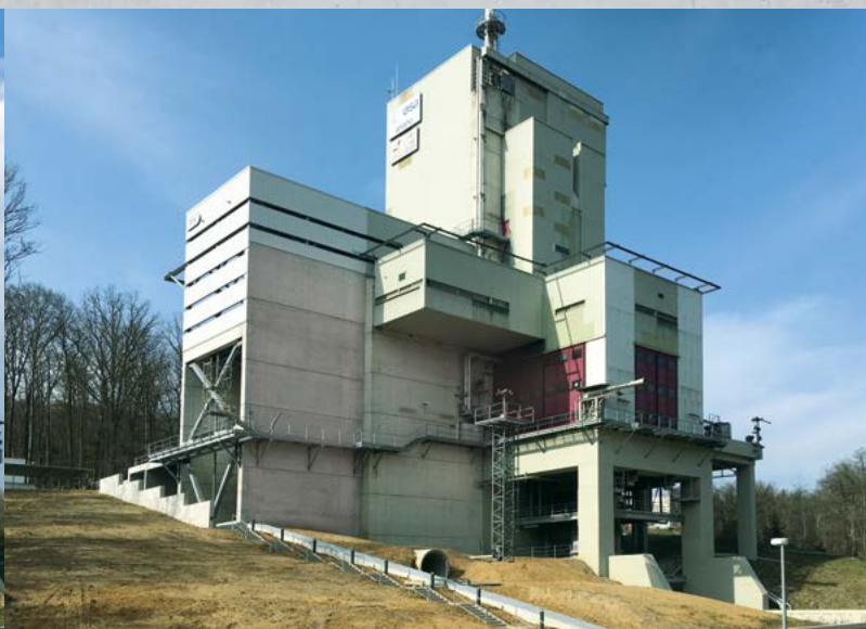
Erweiterung des Raketentriebwerk-Prüfstandes, Lampoldshausen (nachher)
