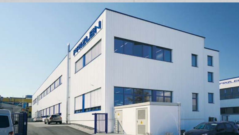
Werk- und Lagerhalle mit Büro und Sozialbereich, Murr
