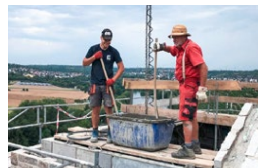
Reinhold Reuschle wird regelmäßig von unseren Azubis beim Bau seines Weinberghauses und beim Erhalt seiner Weinbergmauern unterstützt.
