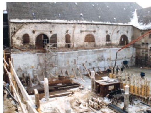
Tiefgarage, Alte Kelter, Besigheim, 1985
