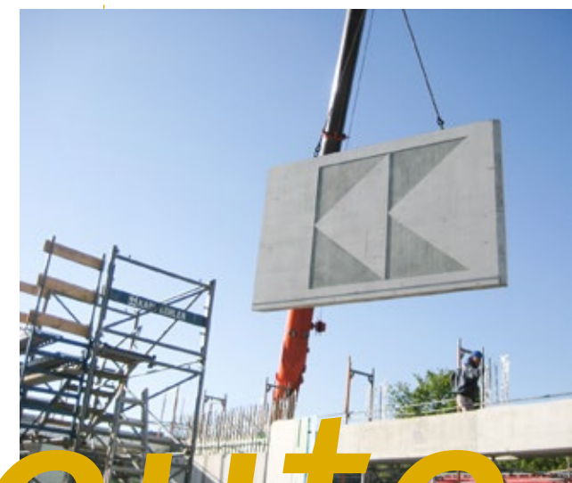
Transluzentes Betonteil für den Eingang unseres Bürogebäudes wird eingehoben.
