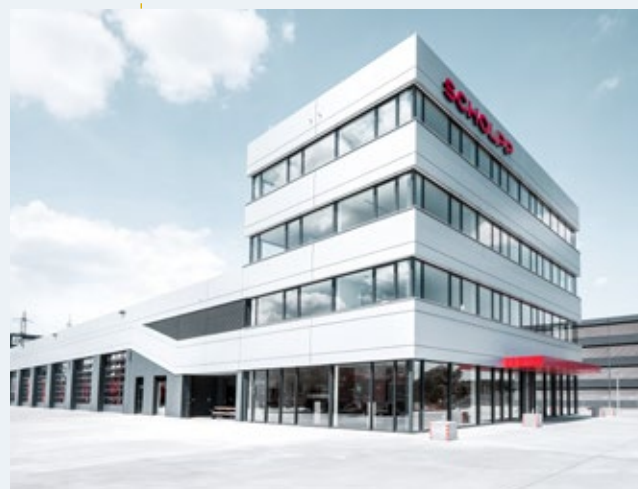
Bürogebäude mit Werkstatt, Leonberg, 2020
