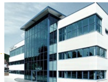
Produktions- und Entwicklungsgebäude, Besigheim, 2008
