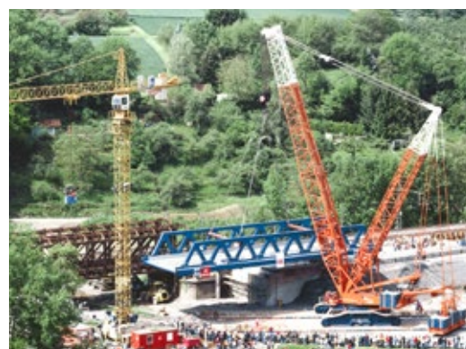
Neue Bahnbrücke über die Enz in Besigheim, 2006
