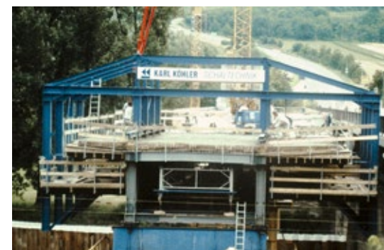
Erneuerung der Neckarbrücke zwischen Kirchheim und Gemmingen, 1997
