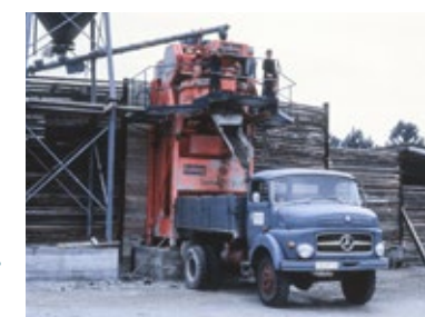
Betonmischanlage Bauhof, Besigheim
