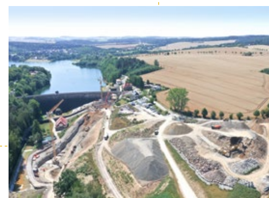
Hochwasserentlastung Talsperre Malter, 2023
