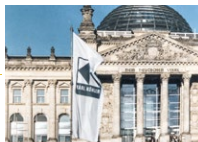
Baustelle vor dem Reichstag in Berlin
