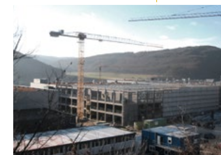
Erweiterung Produktionshalle, Oberkochen, 2012
