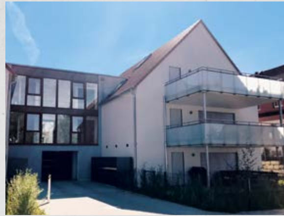
Mehrfamilienhaus, Bietigheim-Bissingen (8 Wohneinheiten)
