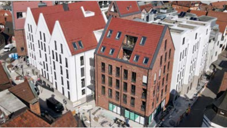
Wohn- und Geschäftshäuser, Backnang (44 Wohneinheiten, 3 Gewerbeeinheiten)
