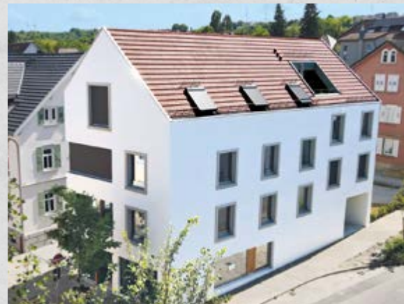
Mehrfamilienhaus, Besigheim (6 Wohneinheiten)
