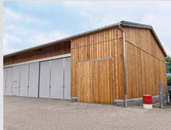
Lagerhalle, Bauhof Flein
