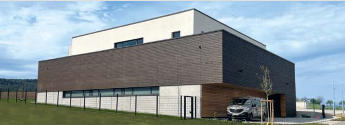
Halle mit Büro, Güdingen
