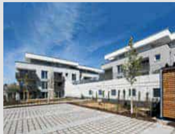
Mehrfamilienhaus, Brackenheim (22 Wohneinheiten)
