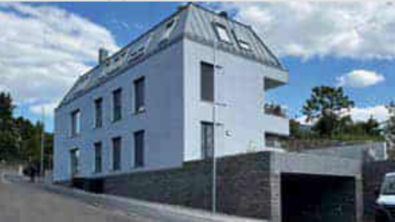
Mehrfamilienhaus, Besigheim (6 Wohneinheiten)
