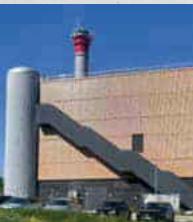
Energiezentrale Ludwigsburg (Hülle dicht)
